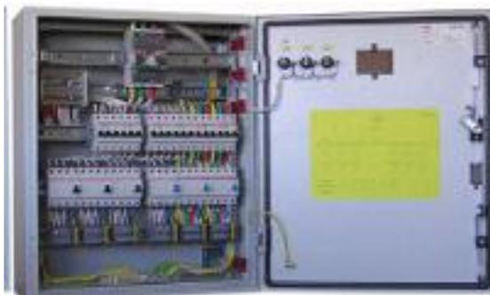
ЩР и ЩО - щиты распределительные и освещения предназначены для приема и распределения, а также для защиты от токов перегрузки и токов короткого замыкания групповых и одиночных линий.
